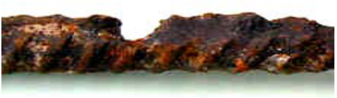
Fig.I.3 : Piqûres de corrosion dues aux chlorures.
