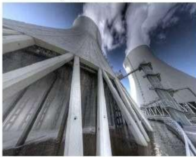
Aéroréfrigérant à tirage naturel
