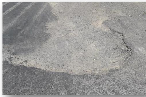
Figure II-9 .Dégradation d'arrachement.
