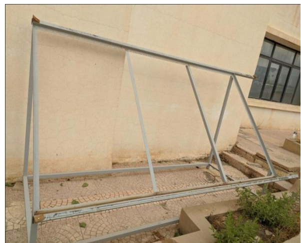
Figure III.16 support de fixation de Panneaux solaire
