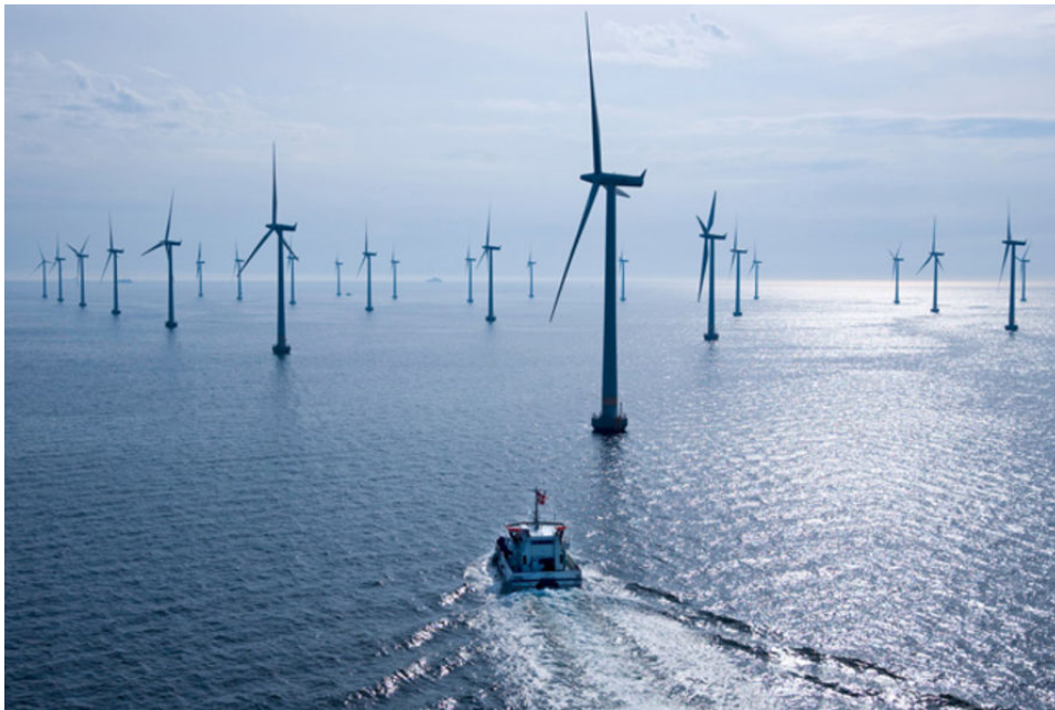
FIGURE 1.12 – Parc éolien offshore
