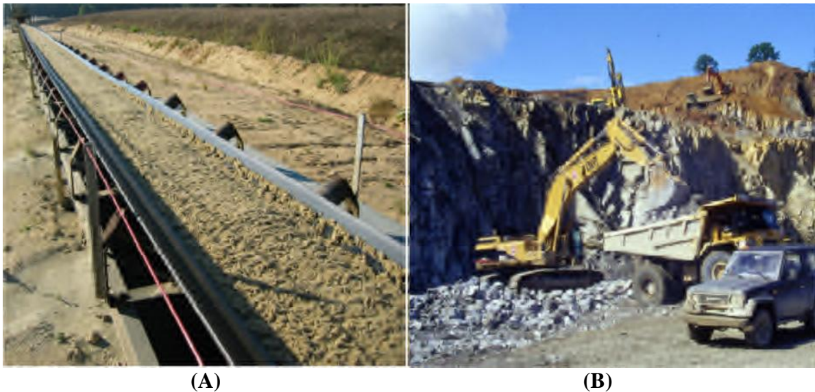
Figure I.6 : Moyens de transport, (A) Bande transporteuse, (B) Dumper.
