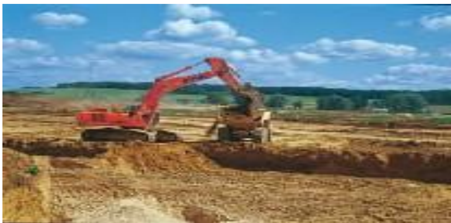
Figure I.2 : Décapage (ou découverte).
