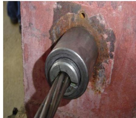
Fig.VI.10 : clavette d'ancrage
