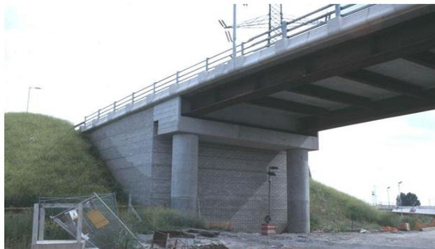
**Fig.III.3: la culée d'un pont**
