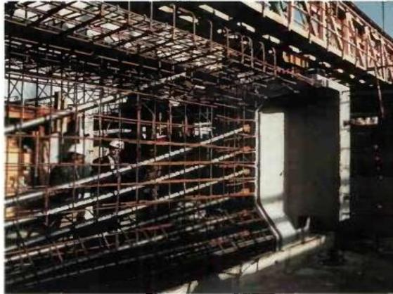
Fig.IV.8 : ferrailage en place centre de poutre préfabriqué.
