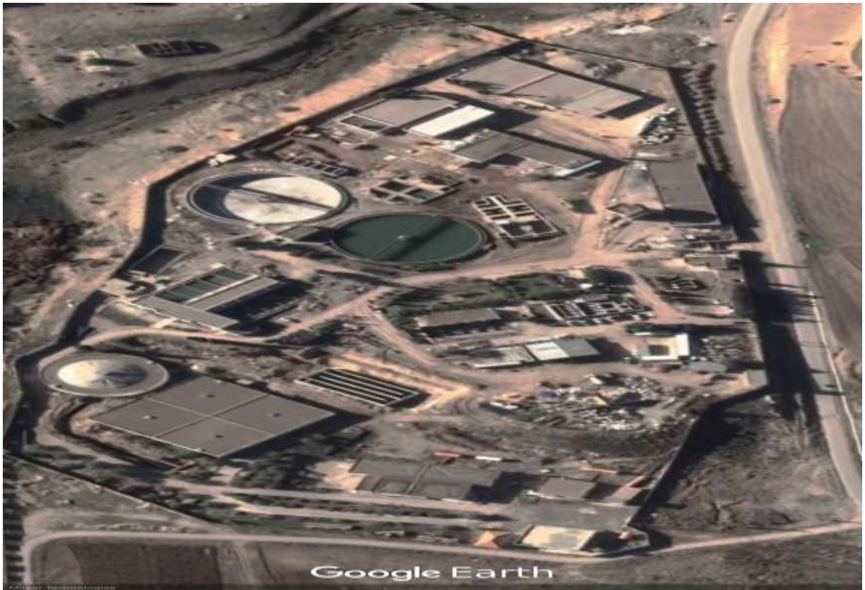
Figure I.1: photo par satellite de la station d'épuration de la ville de Sétif (Google Earth).
