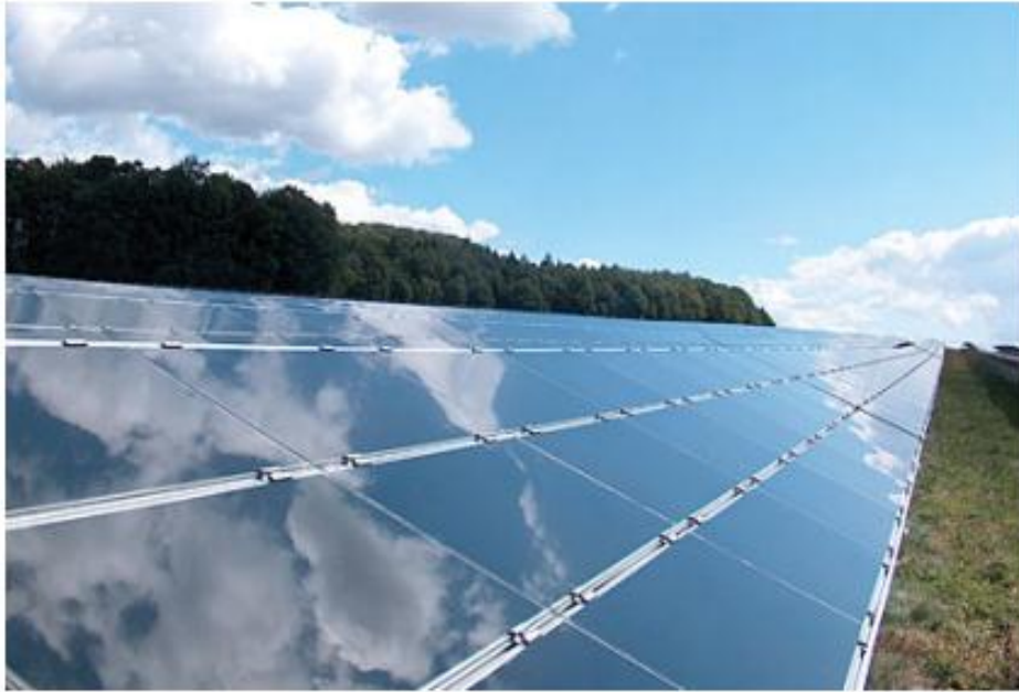
Figure 1.9. Modules verre-verre au Telluride de Cadmium, efficacité de 9 à 11% [13].
