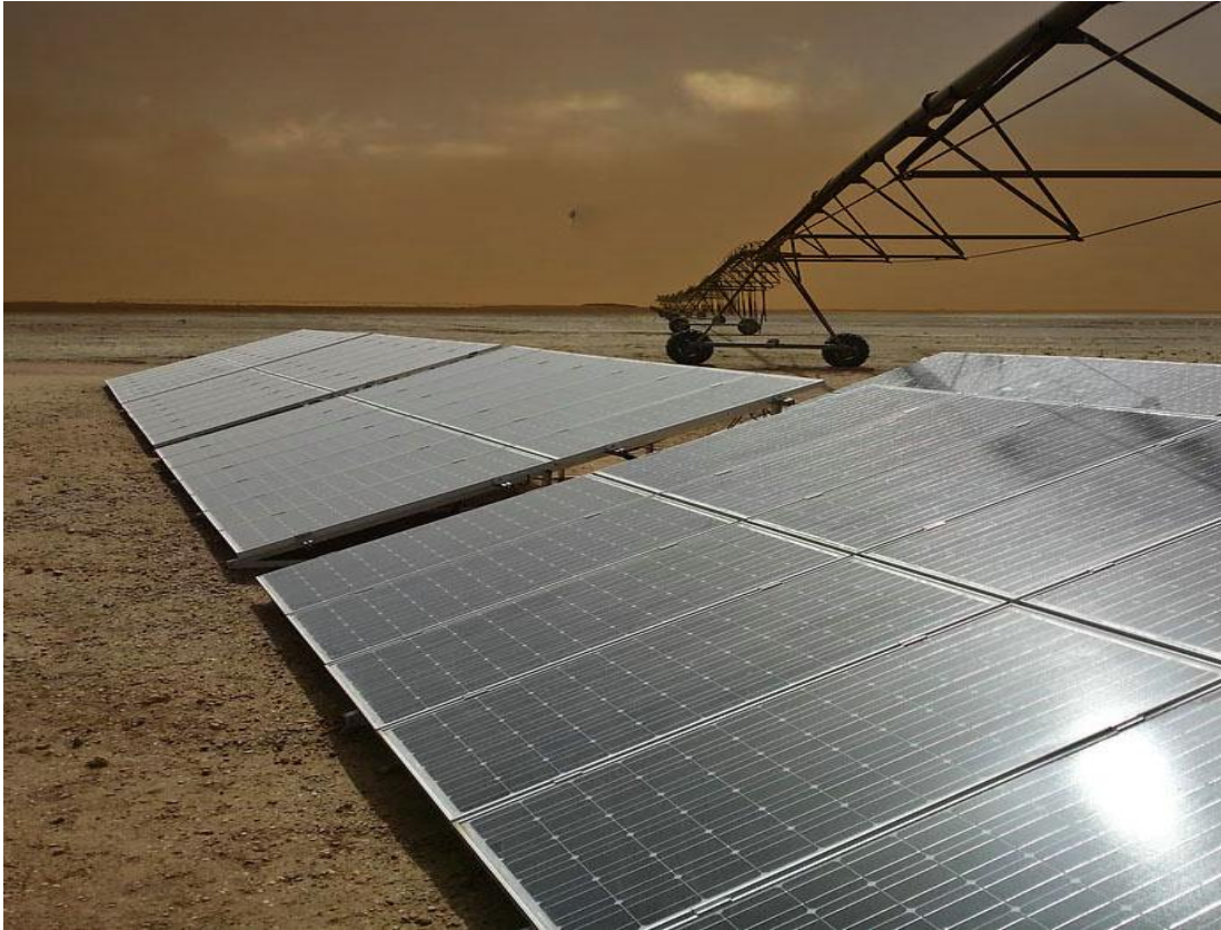
Figure 4.22. Installation de panneaux solaires Panneaux solaires au sol (9).
