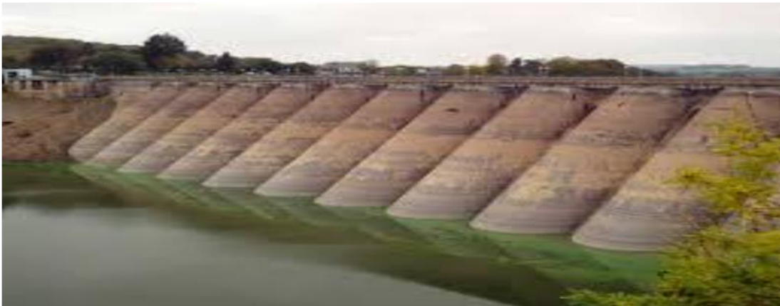
Figure I.9. Barrage à Multi-voûtes.
