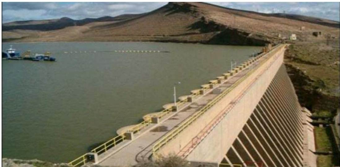
Figure II.2. Photo de la digue du barrage K'sob.
