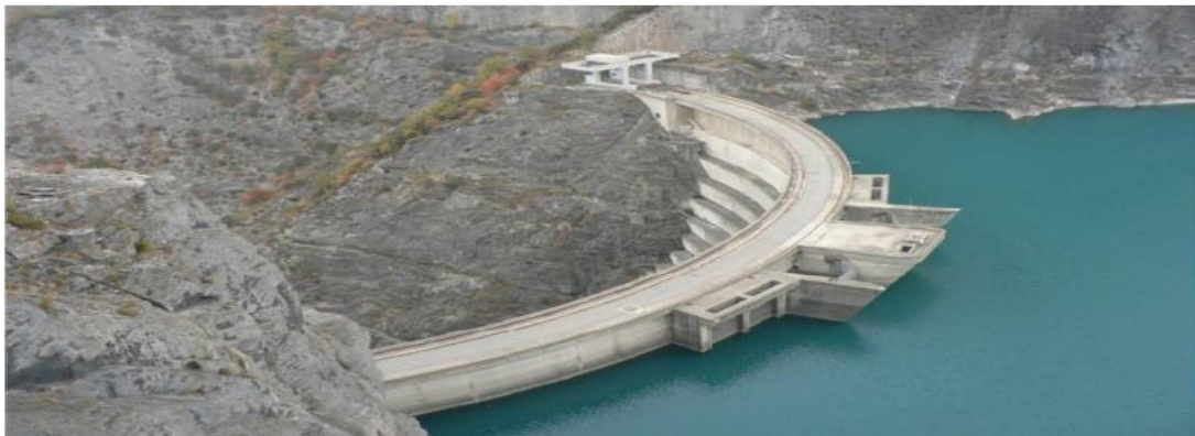
Figure I.5. Photo d'un barrage voûte.
