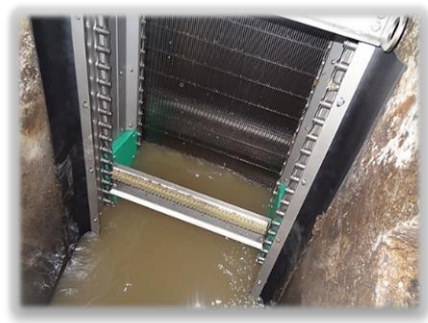
Figure 2 : Dégrillage fin (LADJEL, 2006)
