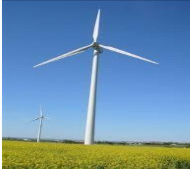
**Figure 1.6 : Éolienne horizontale [10]**
