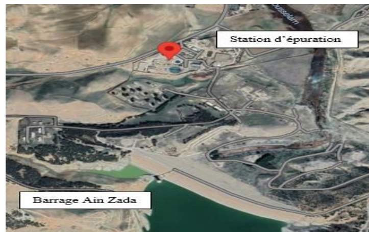
Figure 9 : Station d'épuration d'Aïn Zada
