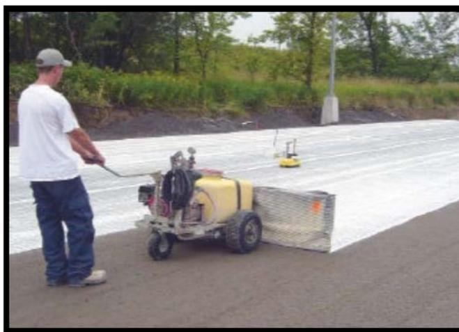
**Figure I.4.** Application d'un produit de cure après compactage du BCR - aire Industriel – Montréal.
