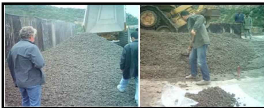
**Figure I.2.** Etat du BCR frais lors de son déversement pour la préparation D'une planche d'essais (Tunisie)
