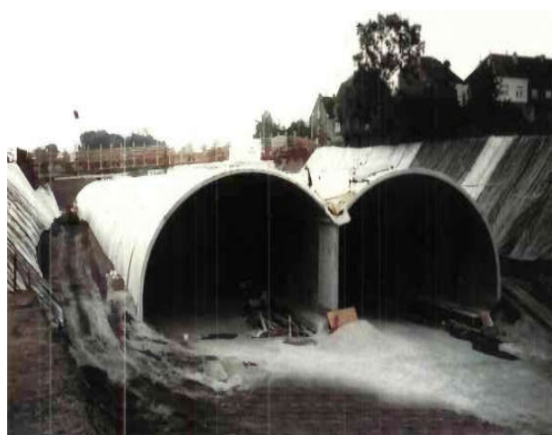
Fig. I.13 : pont tunnel voûté double [7].
