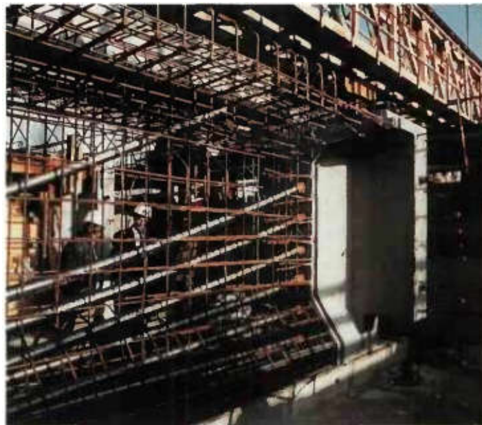
Fig. IV.08 : ferrailage en place centre de poutre préfabriquée [II].
