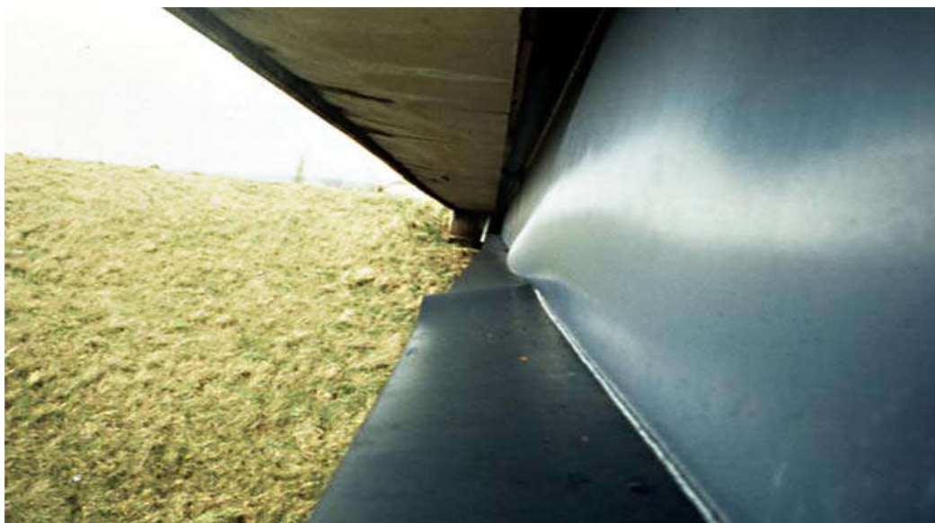
Fig. IV.17 : photo représentative de voilement.
