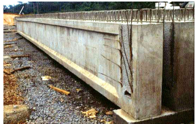
Fig. I.21 : poutre précontrainte [6].
