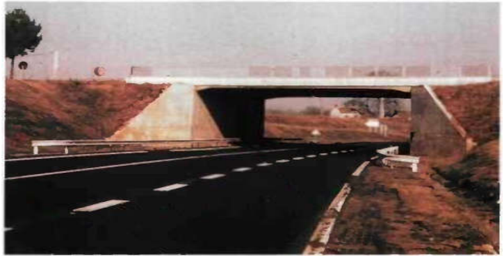
Fig. I.14 : un pont cadre avec murs en aile [4].
