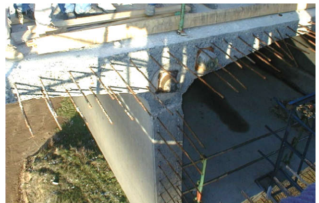
Fig. I.24 : Câblage de précontrainte [8].
