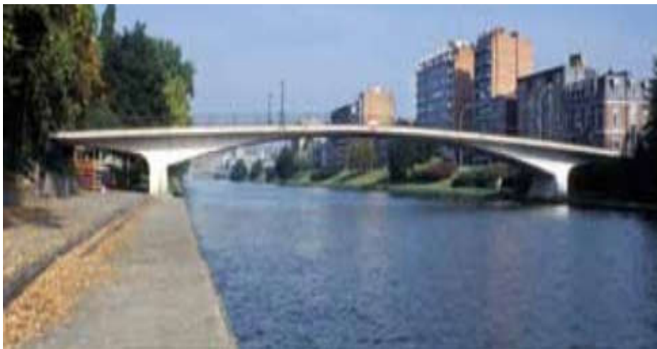
Fig. I.12 : La passerelle Mativa (1905), sur la Dérivation à Liège [II].
