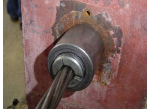
Fig. IV.10 : clavette d'ancrage [II].
