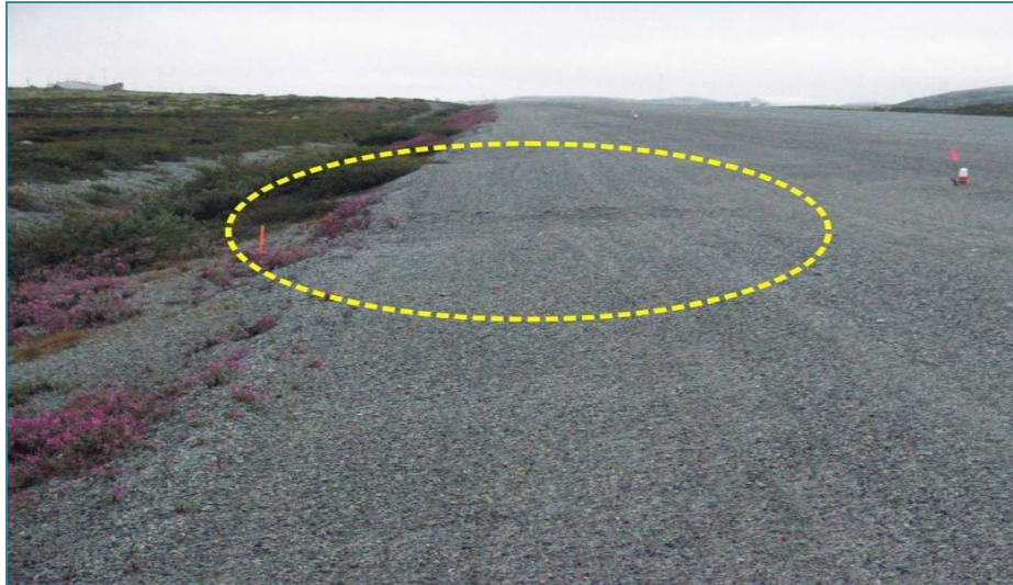
Figure 7: Tassement en bordure d'une route (Amoura et Maameri 2014)
