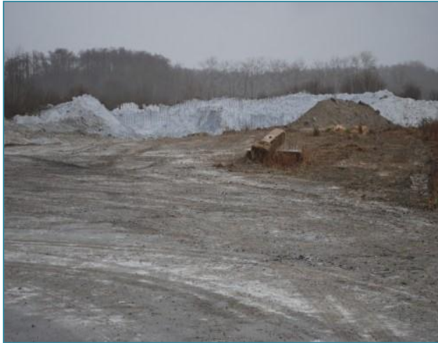
Figure 17 : Dépôt de la chaux résiduaire de l'usine d'El Hadjar (Annaba).
