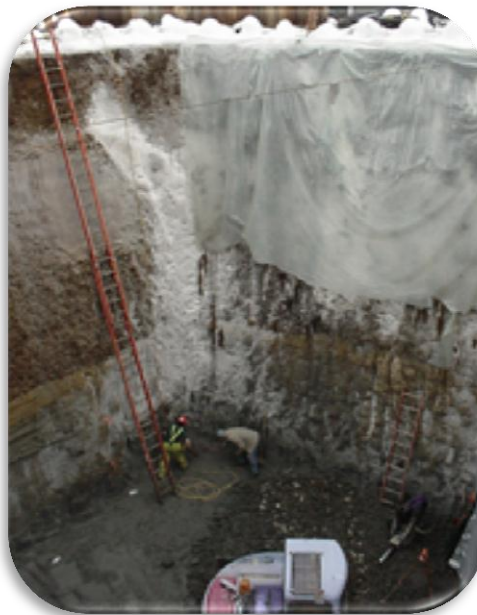
Figure II.6 : Chantier utilisant la congélation du sol (Khebizi, 2011).
