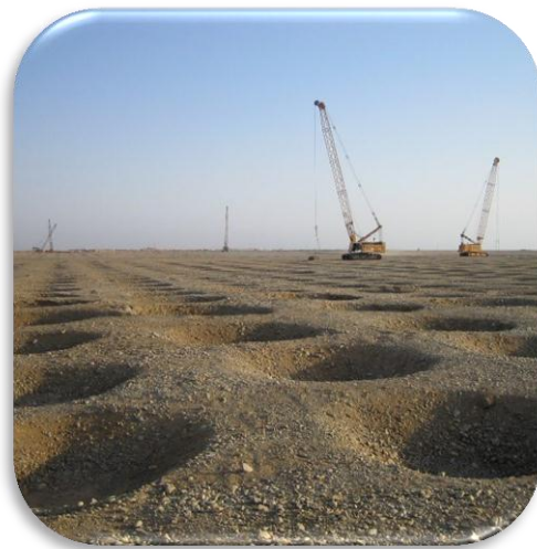
Figure II.2 : Atelier de compactage dynamique et impacts de la masse
