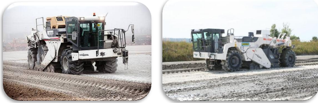
Figure II.4 : Traitement chimique à la chaux et au ciment (Razel, 2007).
