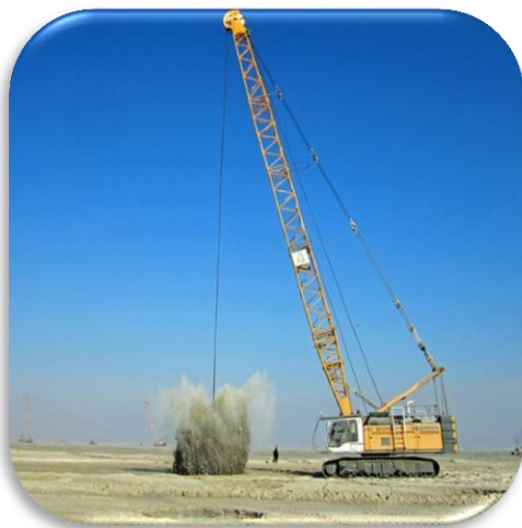
Figure II.2 : Atelier de compactage dynamique et impacts de la masse
