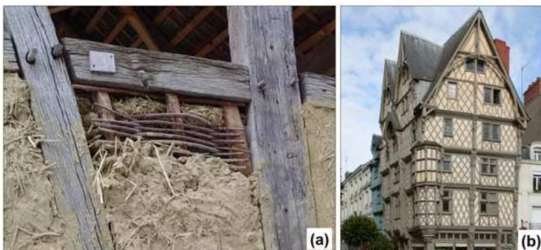
**Figure 1.2.** (a) La technique du torchis illustrée ; (b) Une construction en torchis à Angers, France [4].
