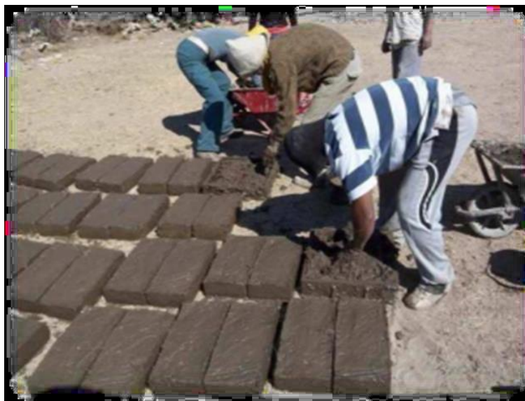
Photo 1.1. Des Moulage et séchage blocs adobes
