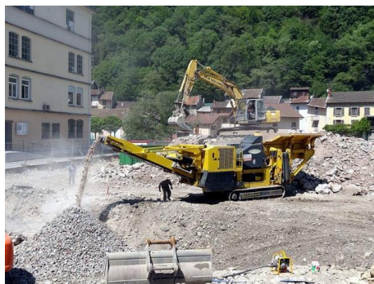
Figure 1. 5 Concassage des déchets de démolition.
