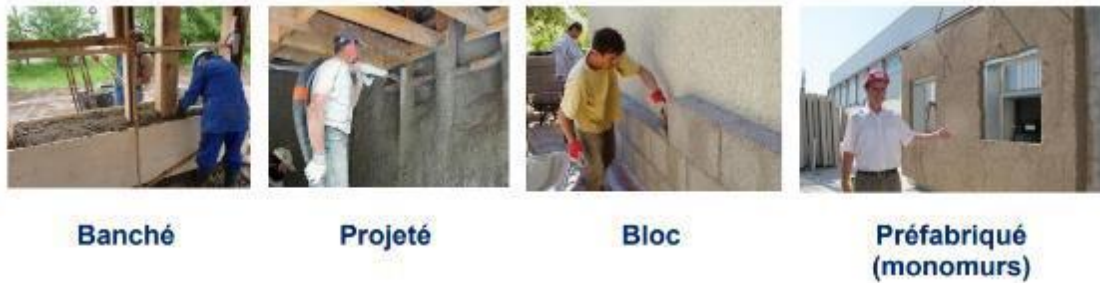
Figure 6: Différentes techniques de mise en œuvre [28]
