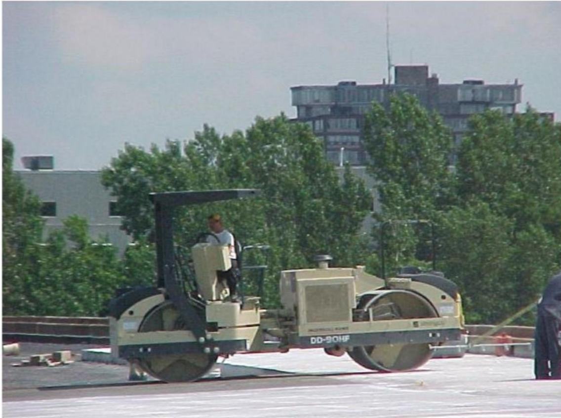
Figure I. 17 Rouleau compacteur tandem à cylindres métalliques lisses
