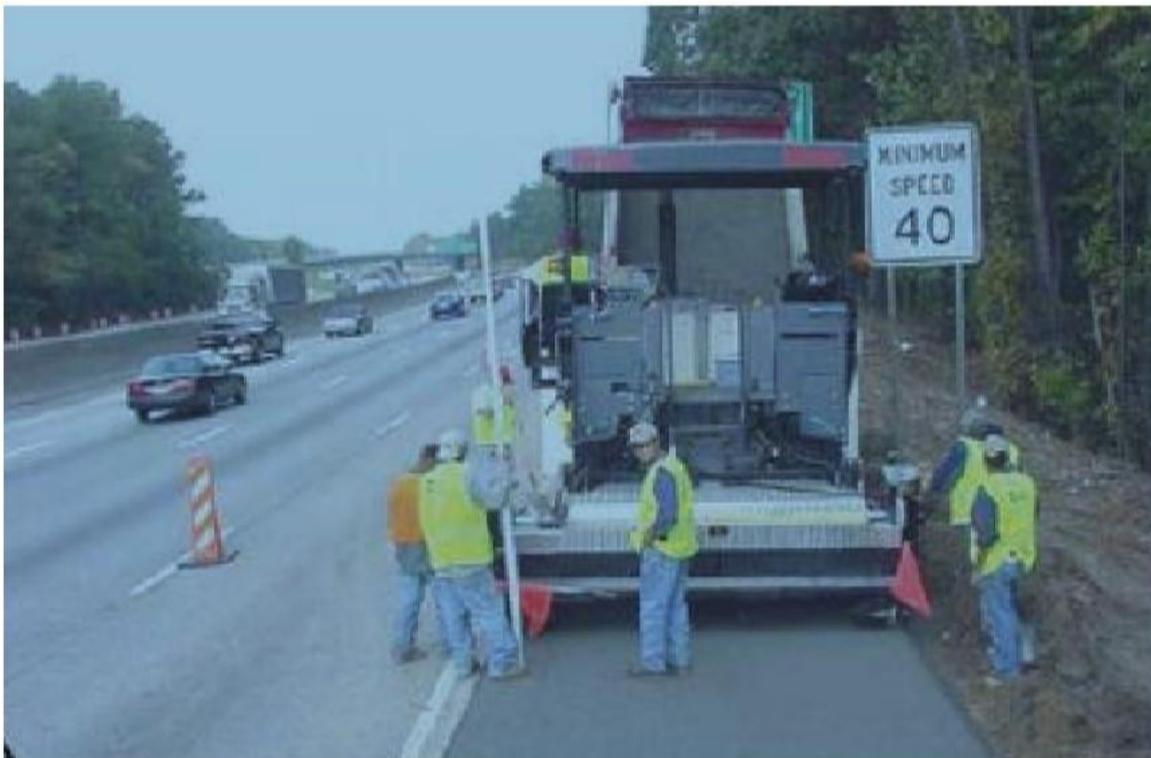
Figure I. 13 Mise en place du BCR en pavage - Atlanta USA (ZDIRI M 2008).
