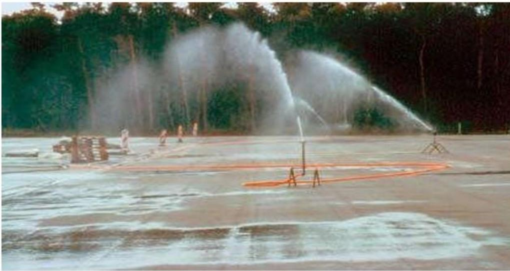
Figure I. 4 Cure du béton par arrosages ciblés (ACI).
