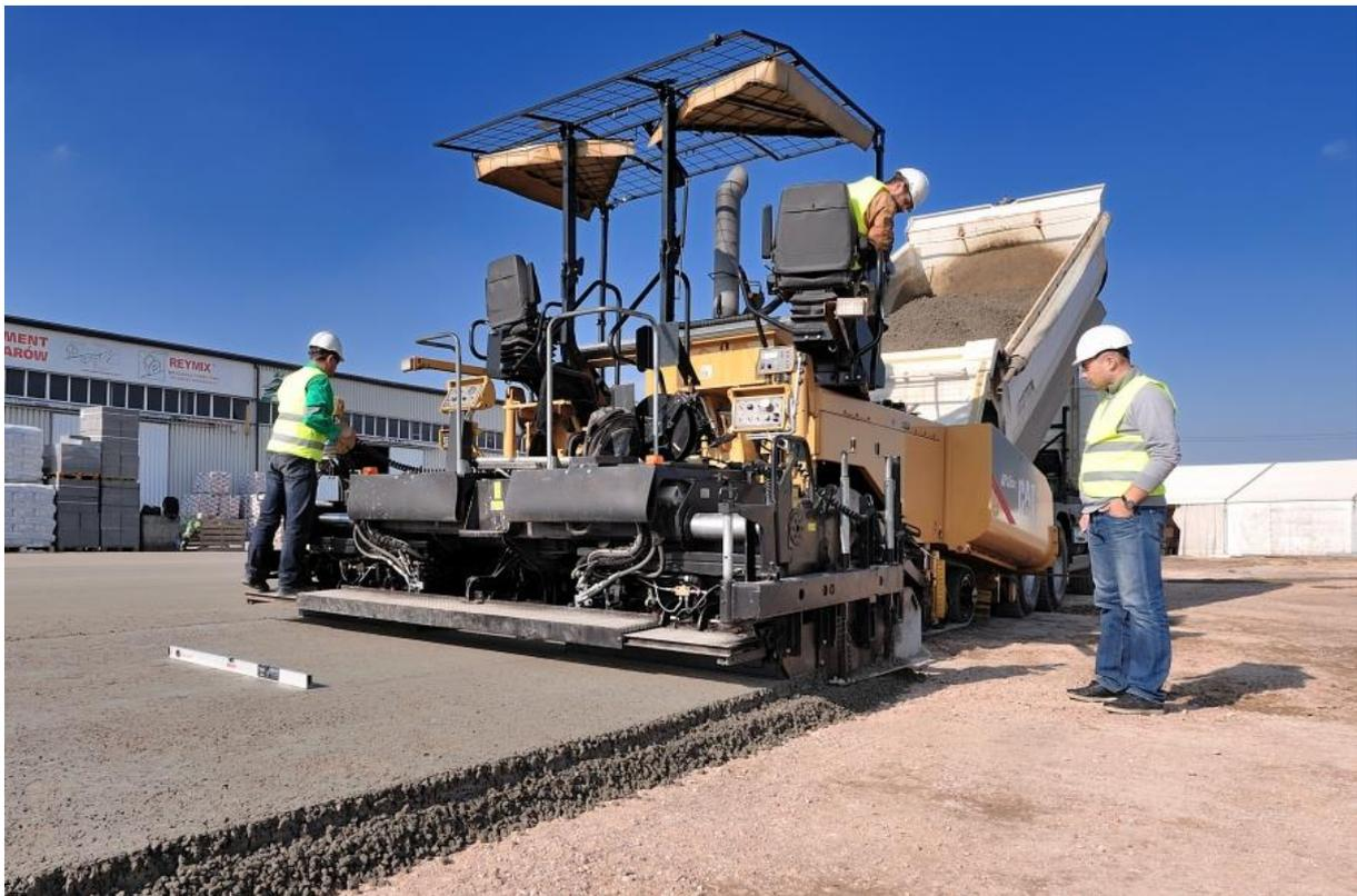
Figure I. 16 Mode de Mise en place du BCR
