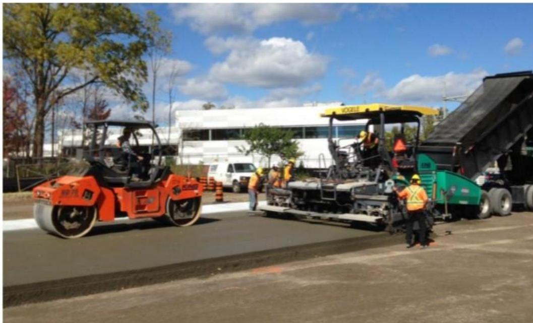
Figure I. 8 Mise en place rapide
