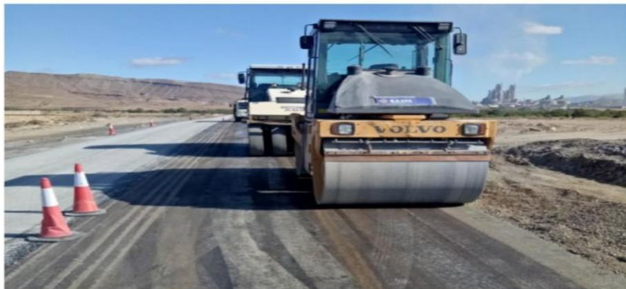
Figure I. 2 Mise en place d'un BCR routier (route HAMMAM DALAA).
