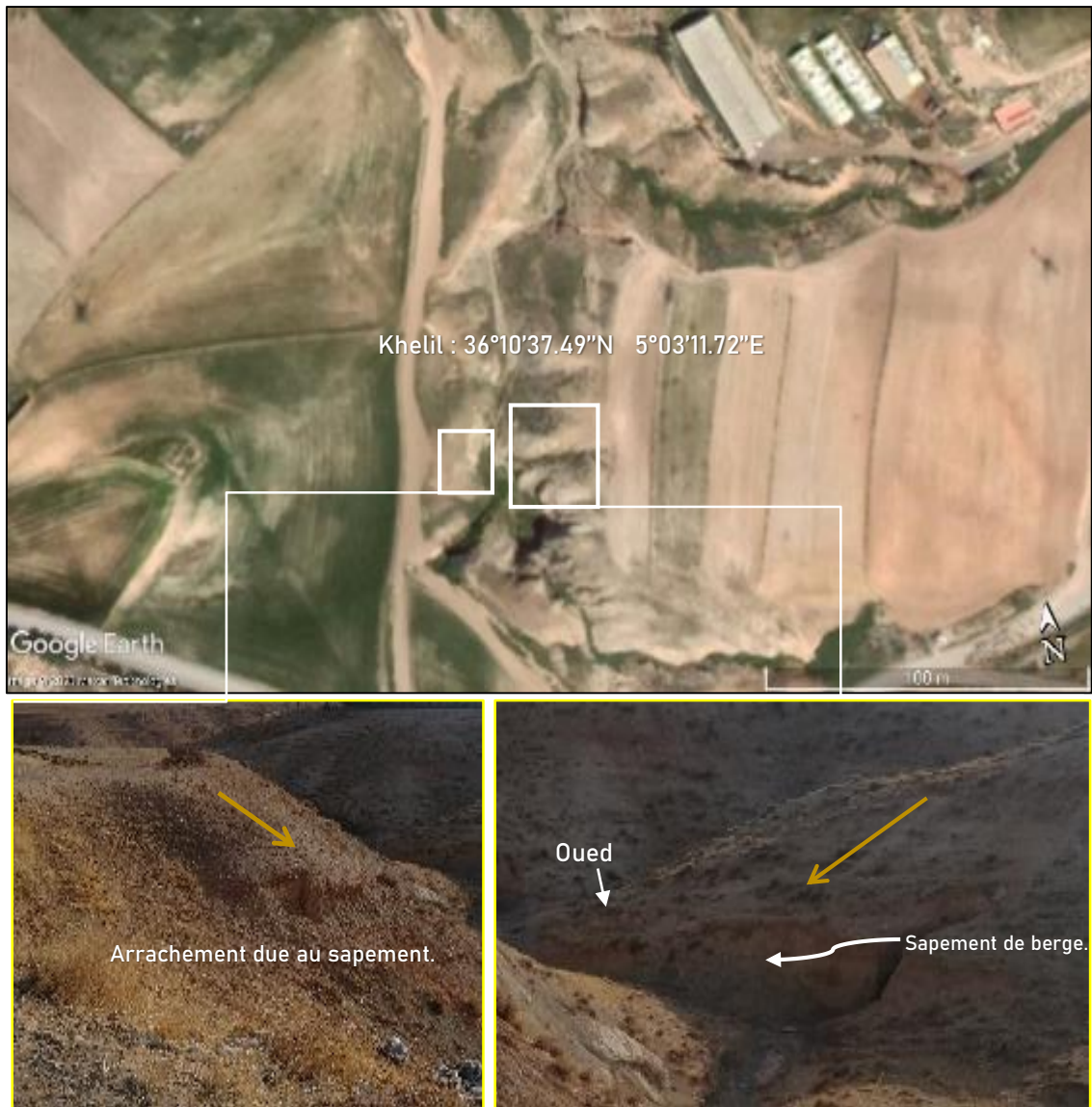
Figure 28 : exemple de sapement des berges conditionne un mouvement de pente sur la zone d'étude.
