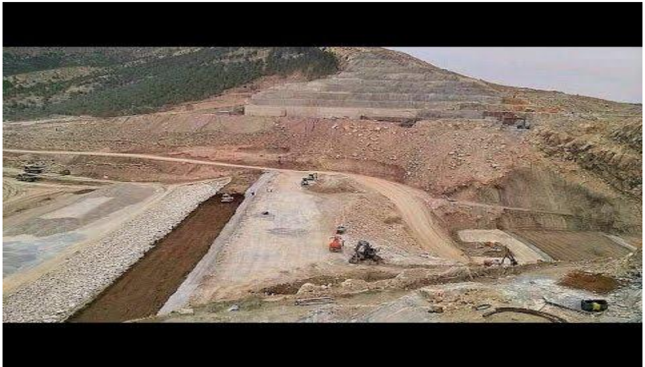
Figure 1.1 barrage de Soubella en cours de construction
