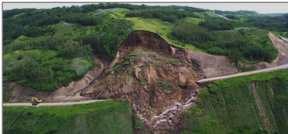
Figure 5: Erosion en masse (Glissement). (Alberta Ouest de Canada).
