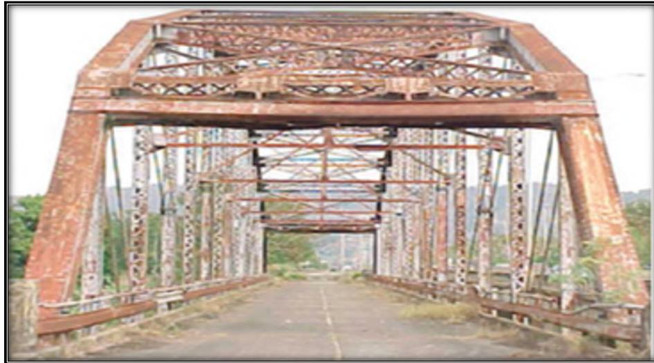
**Figure (I.3) :** La corrosion uniforme d'un pont en acier.
