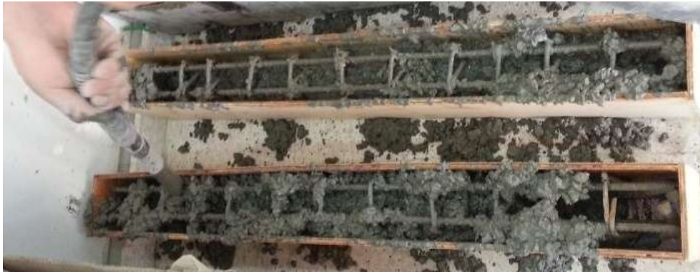
Figure 7.III.2 : Bétonnage des poutres.
