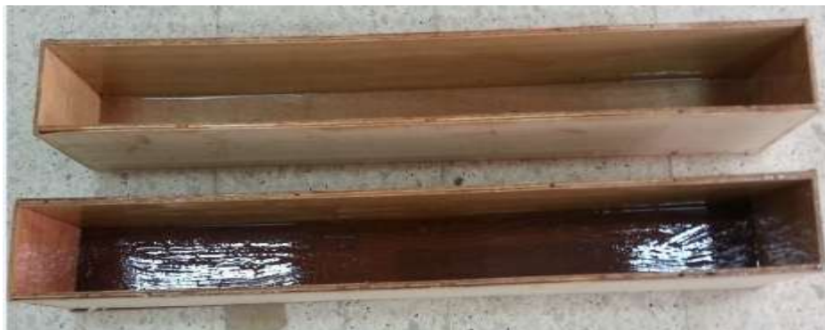
Figure 6.III.2: Coffrage des poutres.
