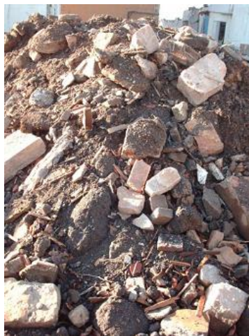
Figure II.7 : Stock de matériaux démolition destiné au recyclage [26].
