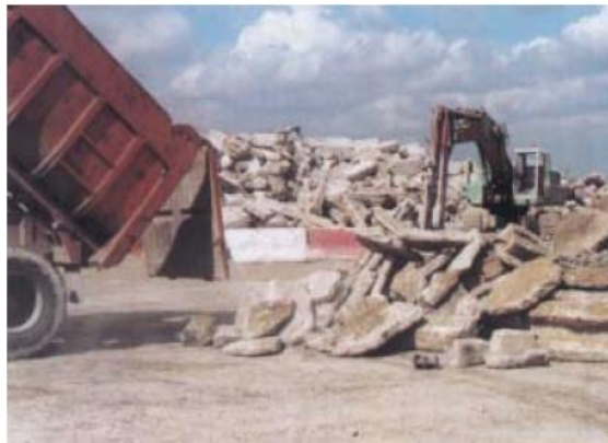
Figure III.6 : Réception des bétons de démolition [26]
