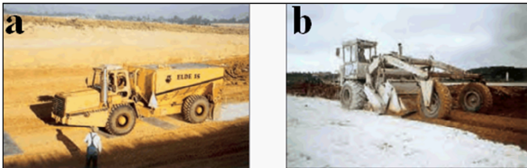
Figure III.8 : Traitement d'un sol pour la réalisation d'une couche de forme : a) Epandeur moderne présentant un coefficient de variation voisin de 5%. b) malaxeur à arbre horizontal garantissant une épaisseur de couche de sol traité constante pouvant atteindre 0.35m avec une finesse de mouture remarquable [7].
