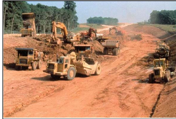
Figure I.7 : Chantier de terrassement Autoroutier [7].
