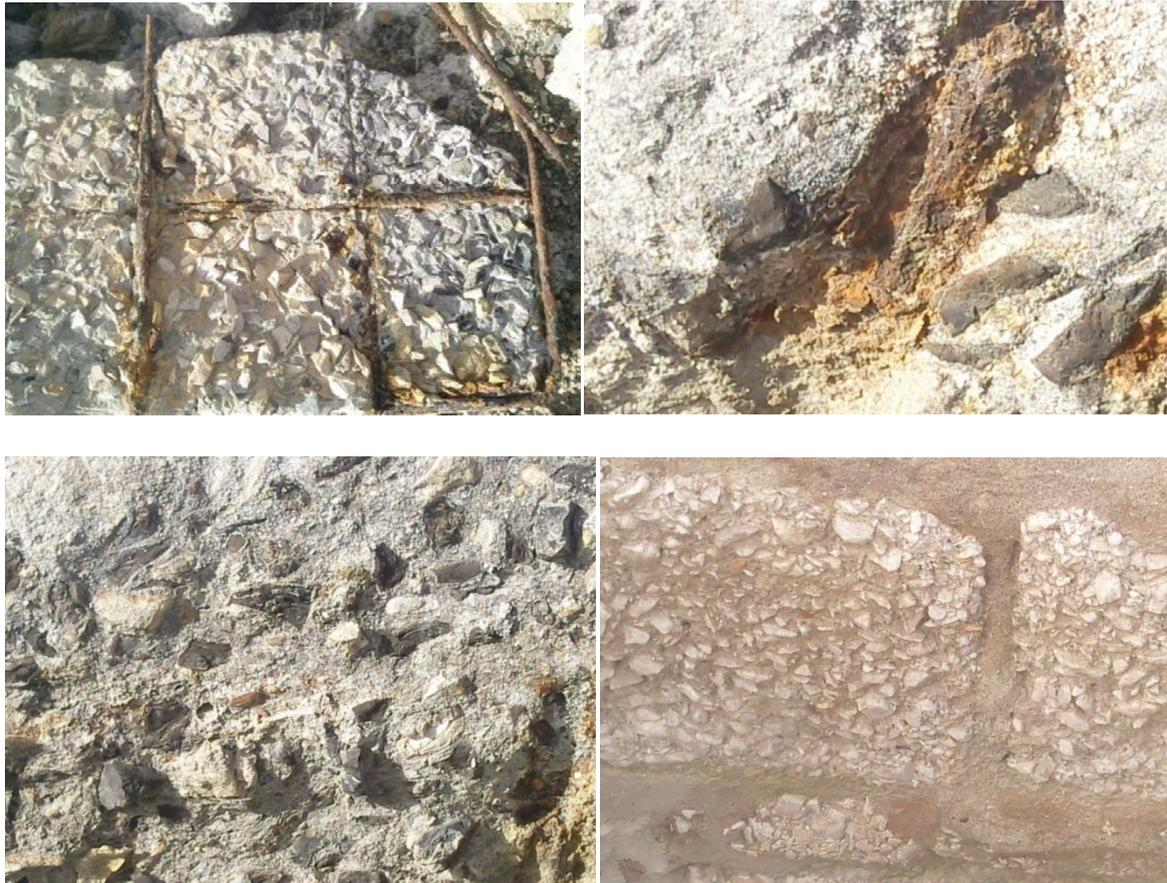
**Figure (II.12) :** Dégradation sur dalles pleines et les tampons
