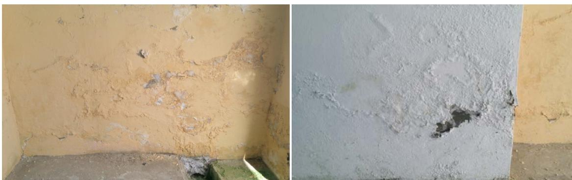
**Figure (II.13) :** Dégradation des murs extérieurs (peinture)
