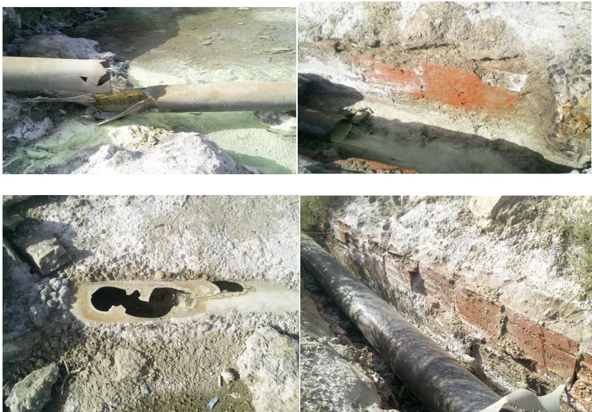
**Figure (II.11) :** Dégradation sur les conduites en PVC
