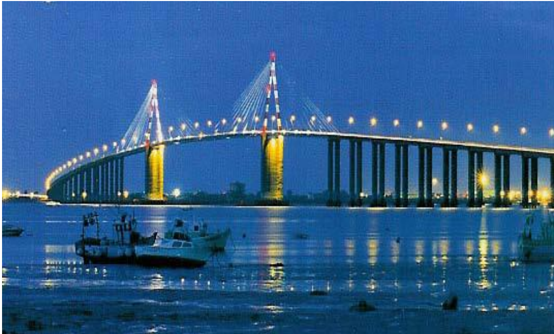
Figure I.1 : Exemple du pont de St Nazaire (France). [2]
