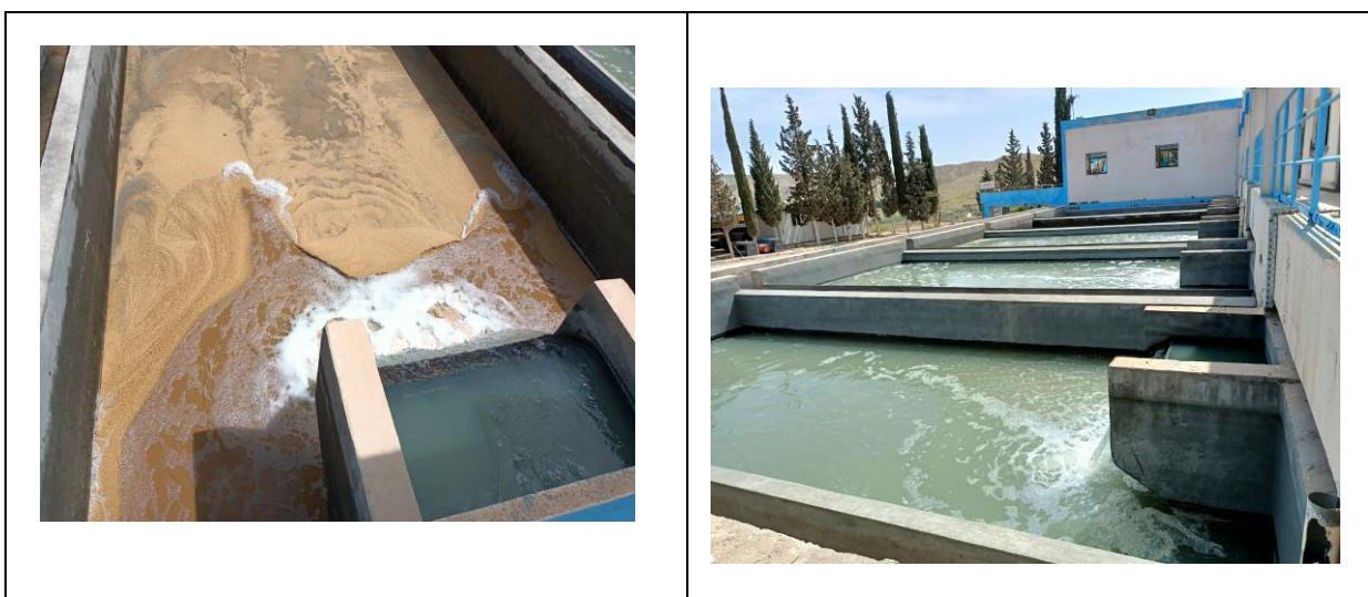
Figure.8: Schéma du système d'une filtration à sable
