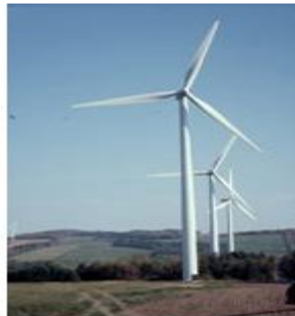
Éolienne à axe horizontal
