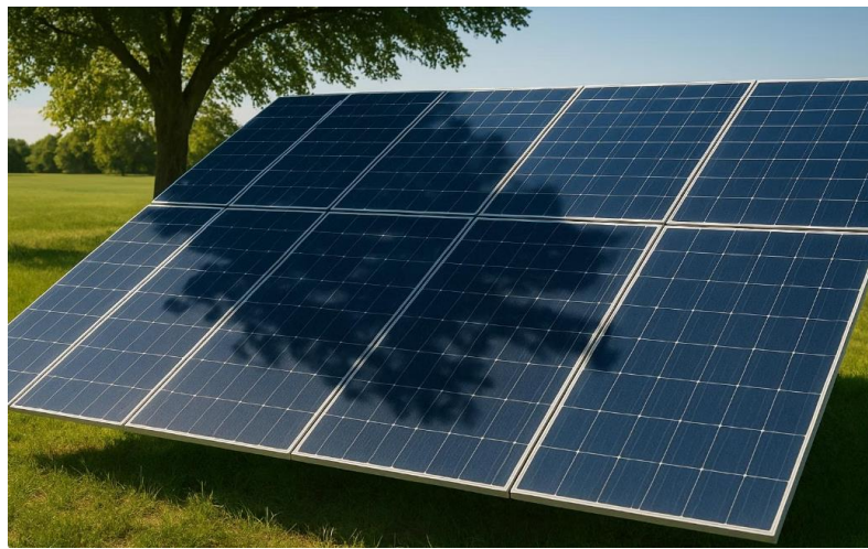
Figure 3. 1 Exemple d'ombrage partiel d'un générateur photovoltaïque causé par un arbre
