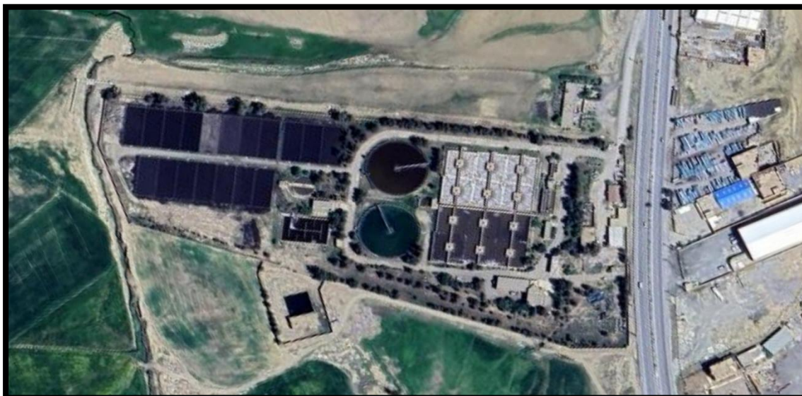
Figure.IV.1. Localisation de la station du traitement de BBA.
