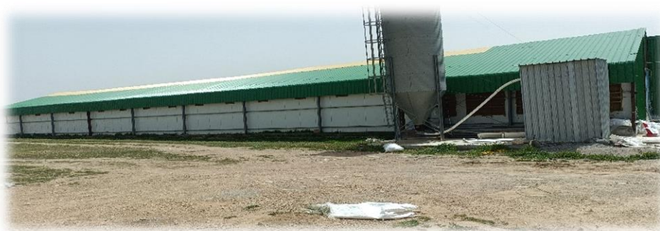
Figure 7: Vue extérieure du bâtiment B02 (Bâtiment obscurci) (photo original,2025)
