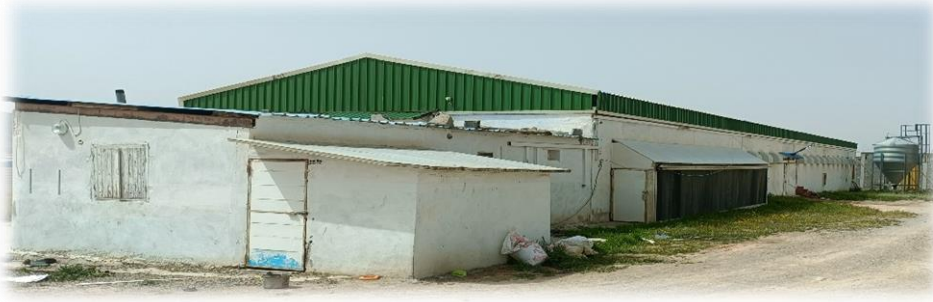
Figure 6: Vue extérieure du bâtiment B01 (Bâtiment obscurci) (photo original,2025)
