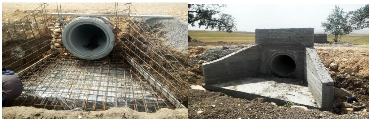
Figure VI. 1 ouvrages de drainage
